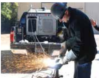
Corte manual en obra
