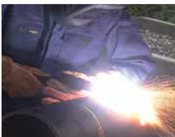
Remoción de soldadura
